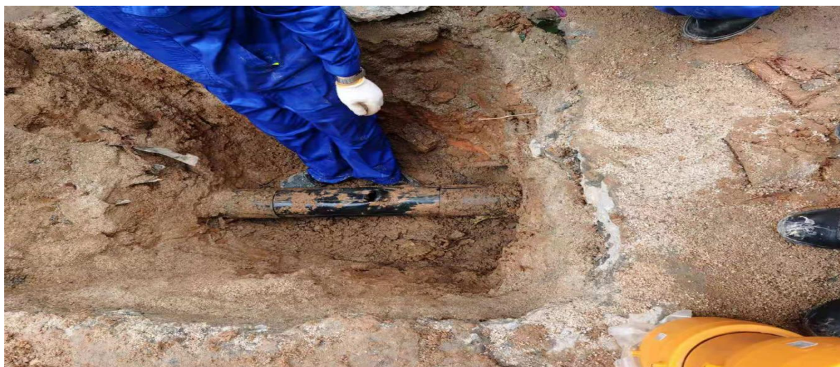
燃气泄漏管段图
