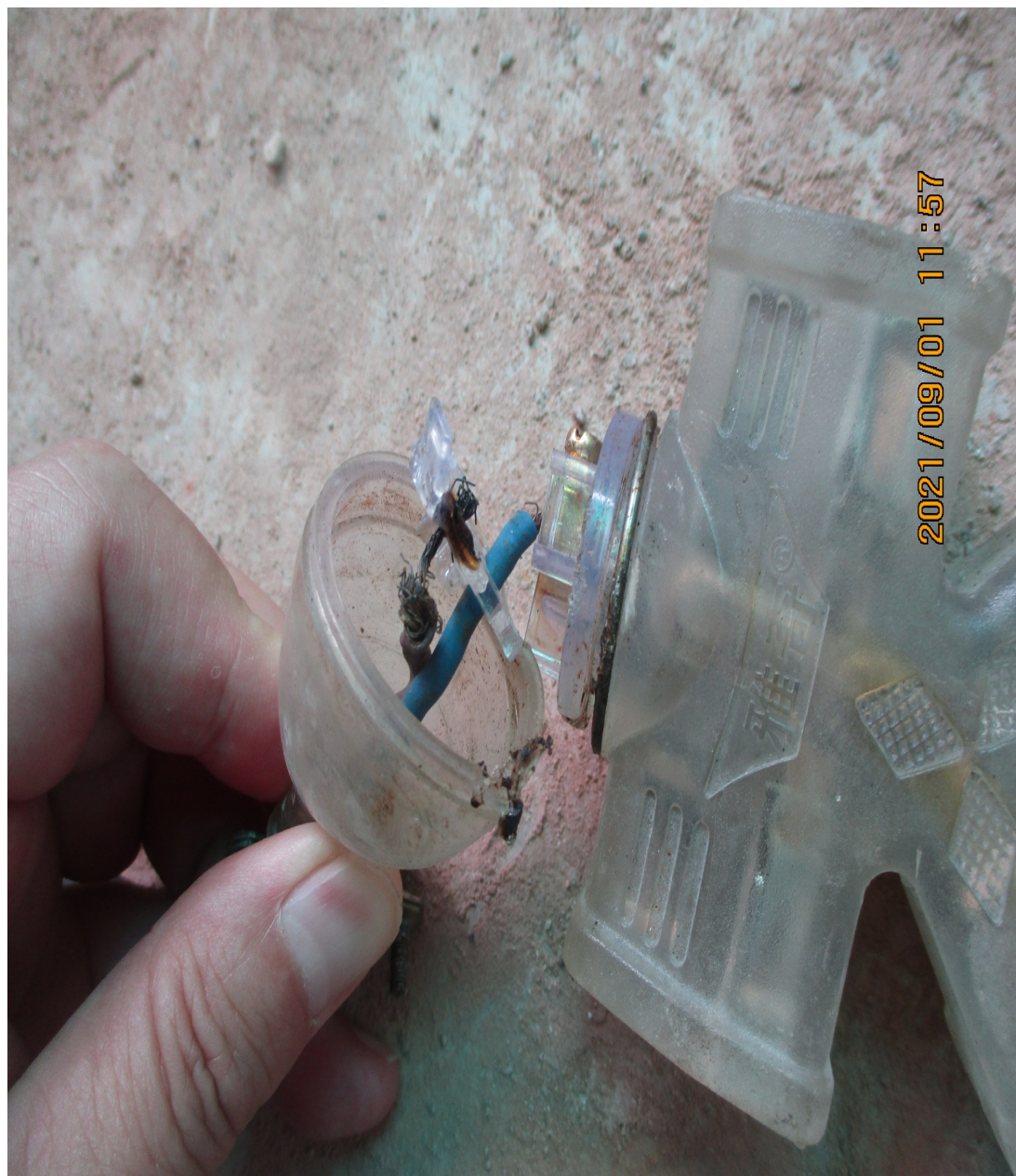
破损的地拖带线多孔插座
