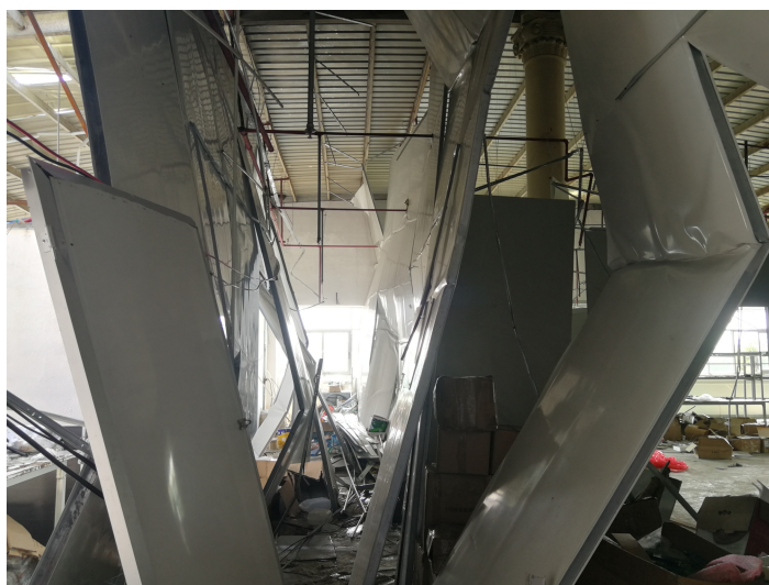
图5 车间南侧通道的铁质隔离墙
