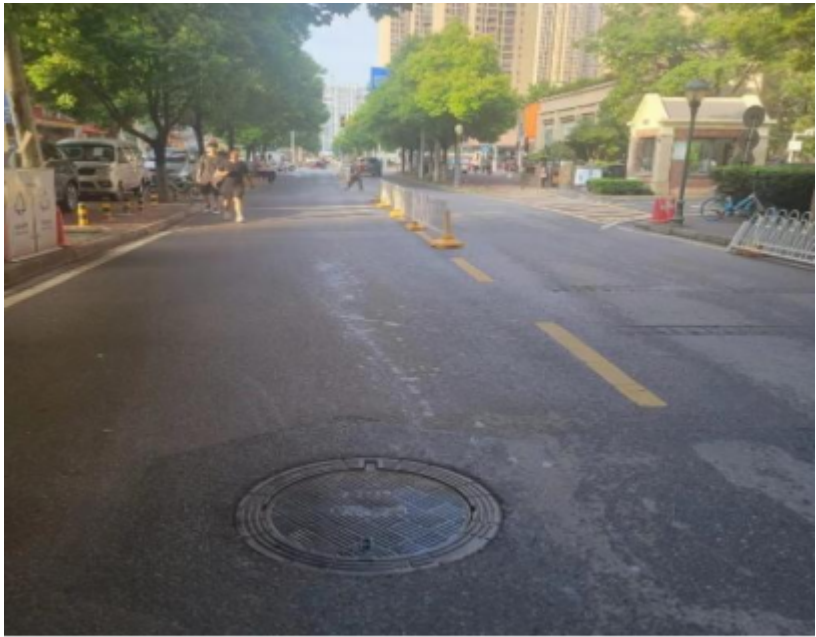
图2 3#污水井井口及周边环境实景照片
