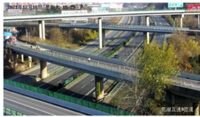
图5 涉事故车组进入钢箱梁桥联段
