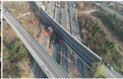
图8 桥梁倾覆现状航拍图
