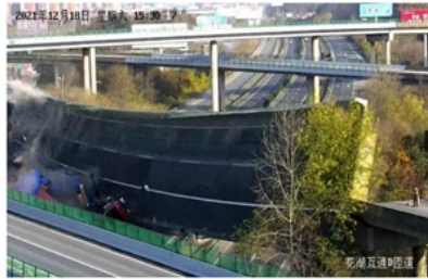
图7 桥梁倾覆落地
