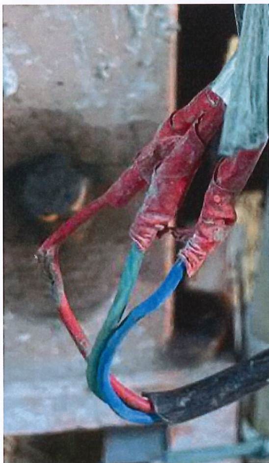
图 3 电缆接驳处导线绝缘层破损
