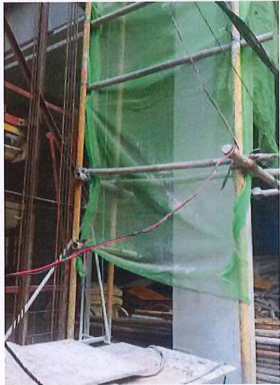
图 7 配电箱使用木板制造且无箱门 图 8 线路直接缠绕在手脚架上未穿管保护
