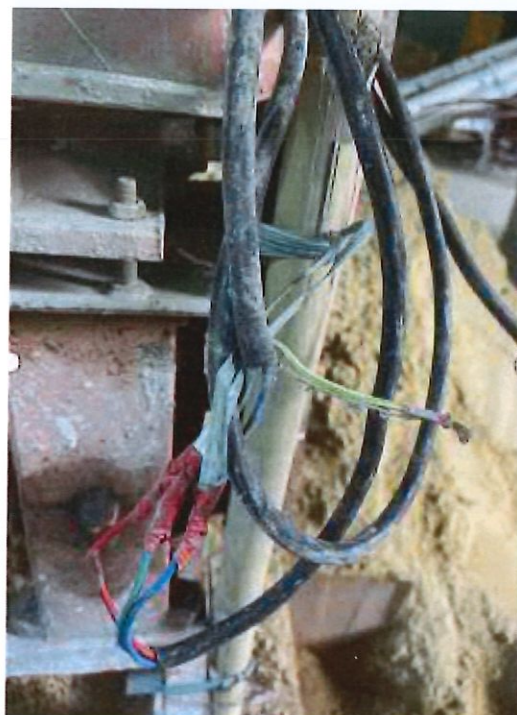
图 5 右侧第 2 组线未安装漏电保护开关 图 6 砂浆搅拌机未做接地保护
