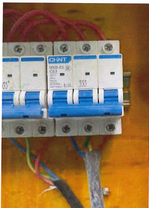
图 5 右侧第 2 组线未安装漏电保护开关 图 6 砂浆搅拌机未做接地保护
