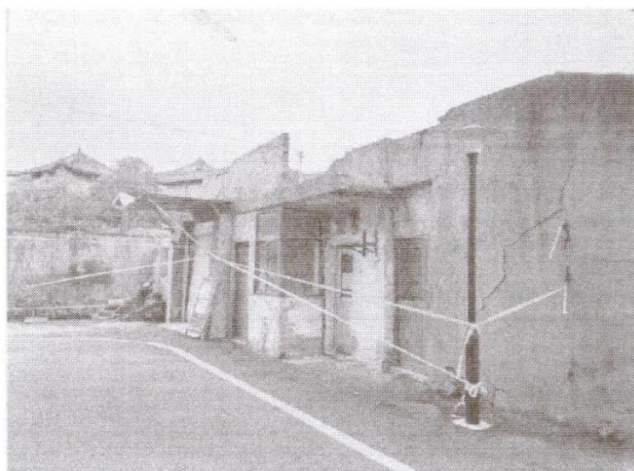
图4 杂物房南面照片
