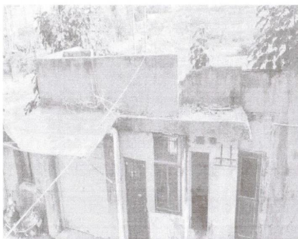
图2 事故发生前南面照片
