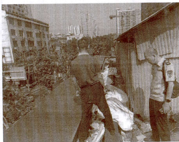
图 5 广告位顶部情况
