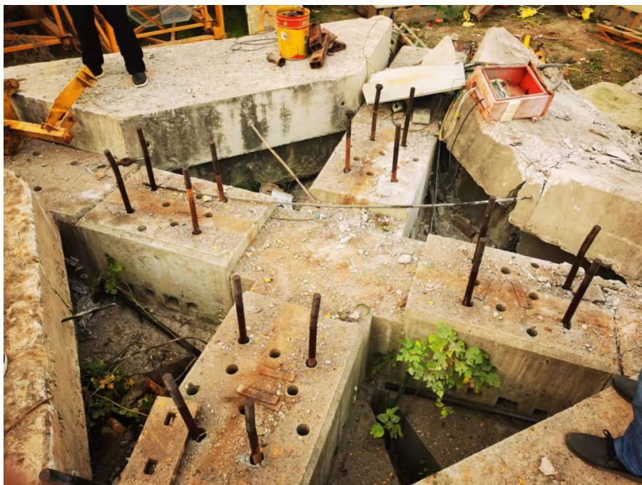
图8 事故后拼装基础
