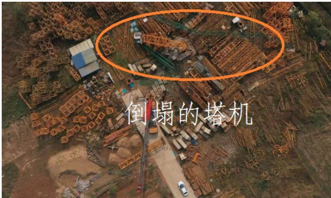
图1事故现场俯视图
