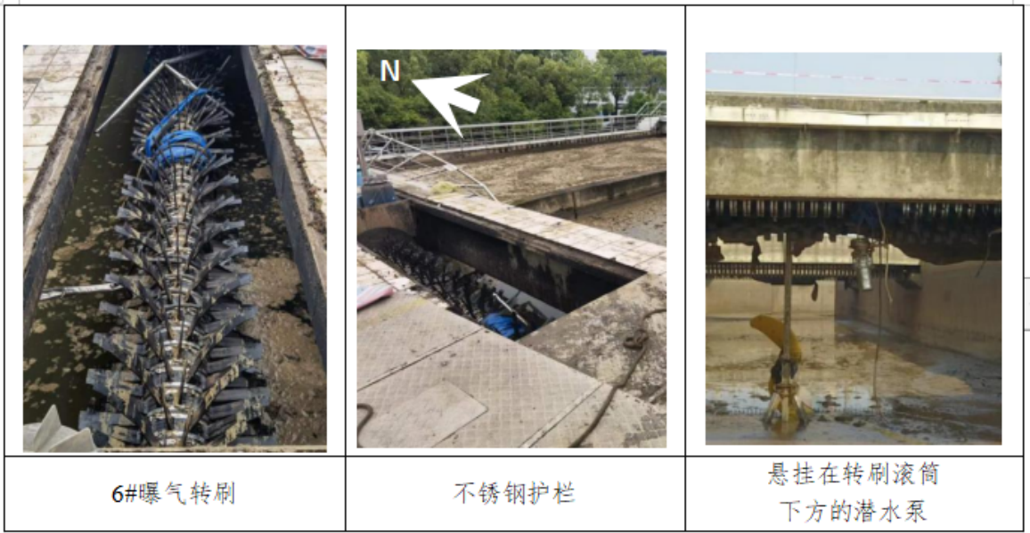
图3：事故现场勘验情况
