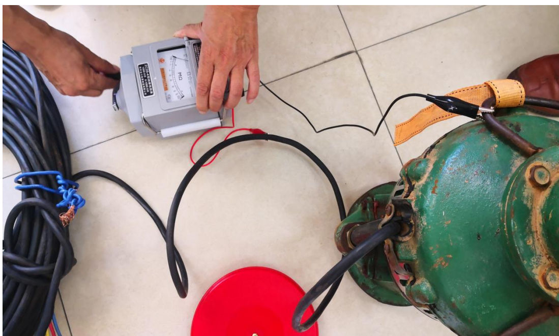
图 6：用摇表对大潜水泵（外观为绿色）电源线破损处的电阻检测
