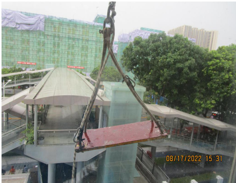
图 2：事发后座板悬停状态
