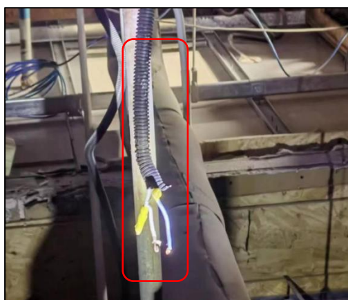
图 3 顶棚上的蛇皮管护套照明线路 图 4 外露的金属线芯
