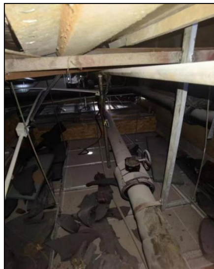
图 2 顶棚上方的金属龙骨架
