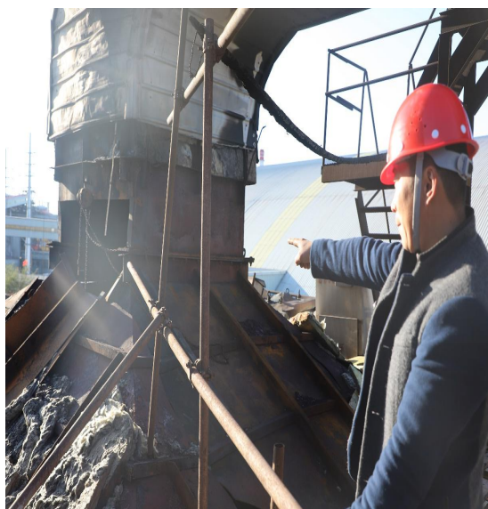
电焊作业地点
