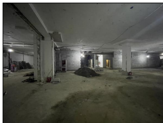
图 2 事发项目一层（楼内）
