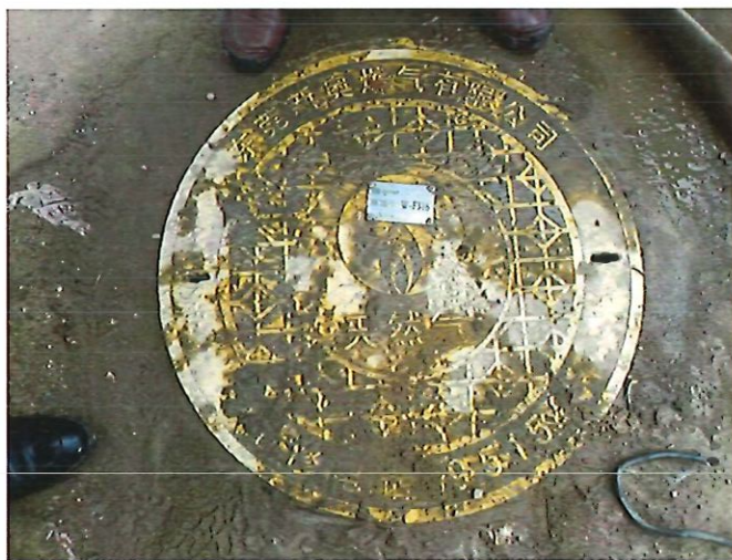
图 3 新奥燃气阀门井盖（中心点距泄漏点 2.2 米）
