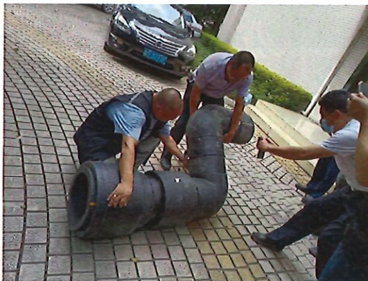
图 4a 切除的泄漏管段还原安装状态
