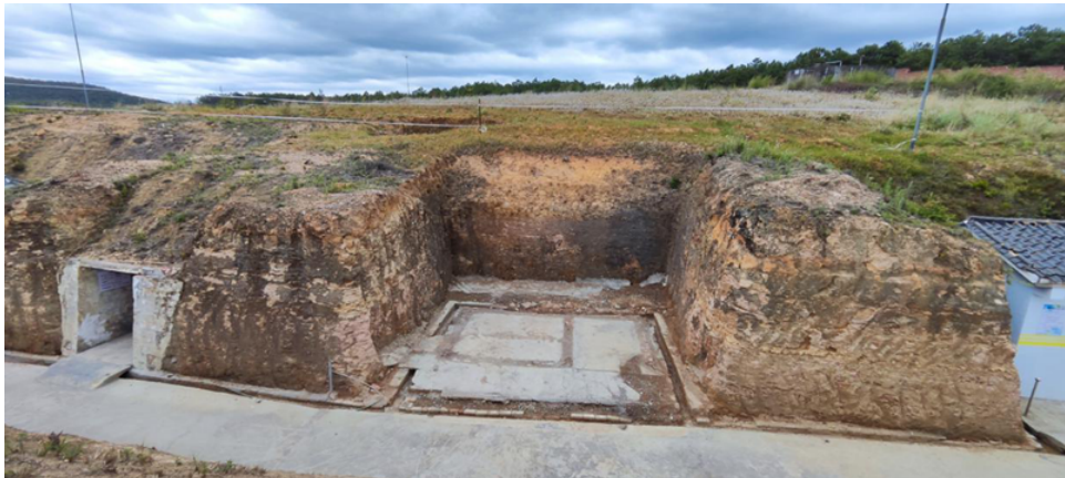
图5 事故现场清理后照片
