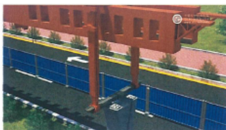
1号腿支于142号墩南侧垫石上
