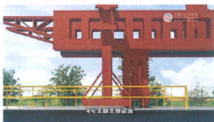
4号腿支于已架好桥面上
