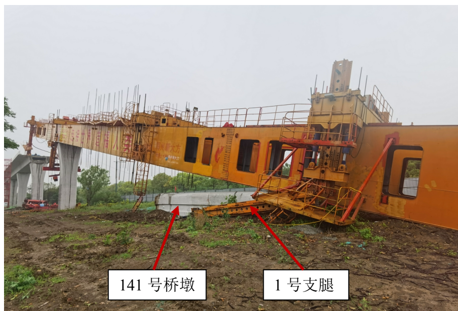
图 1 事发现场倾倒的架桥机
