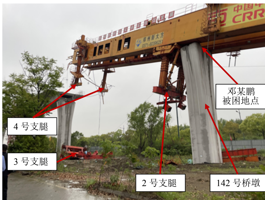
图 2 事发现场倾倒的架桥机
