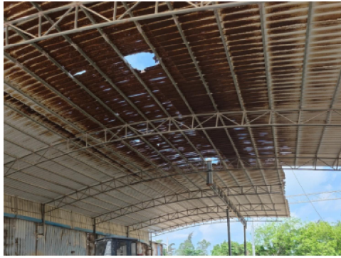
图1 屋顶锈蚀
