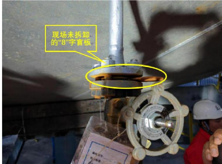
图10 自力式调节阀组罐内引压管线根部取压口被盲板封堵现场照片
