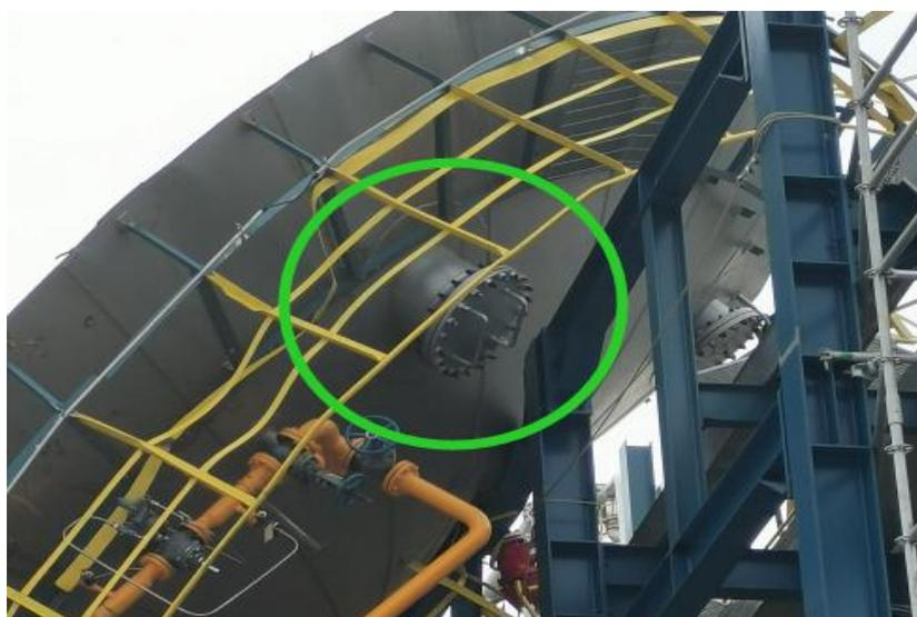
图9 泄压人孔被盲板封堵现场照片
