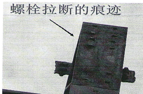
图 14 西北侧钢柱连接板
