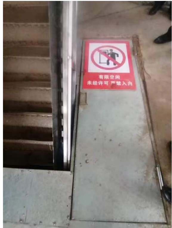
图 9.绿皮仓入口盖板
