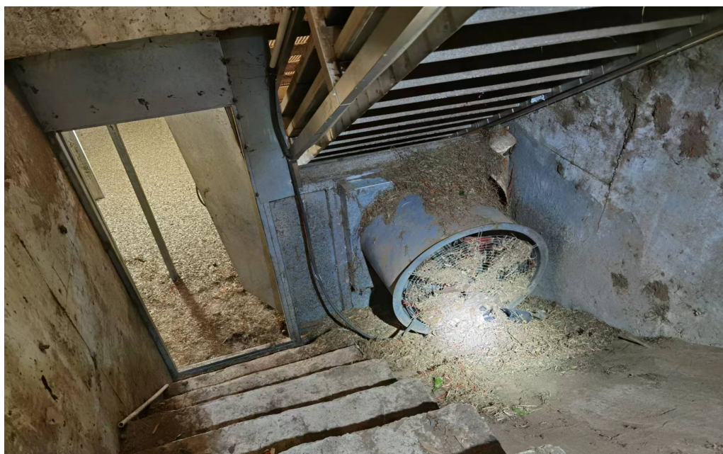
图 7.绿皮仓底部通风机
