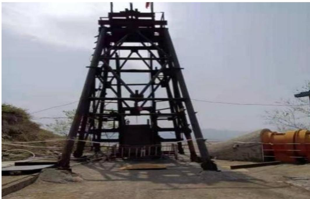
图 1.3 新北采区东 3 号竖井井架及地面轴流式通风机
