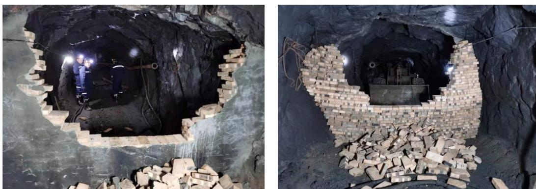
图 4.2 井下 1050m 中段封堵墙
