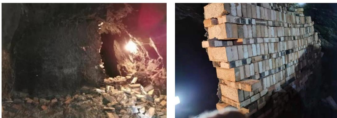
图 4.3 井下 940m 中段封堵墙
