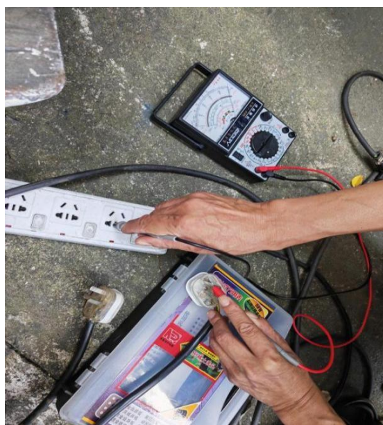
图-18 白色排插地线检测情况
