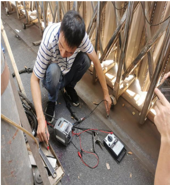
图-13 氩弧焊机通电对地电压检测
