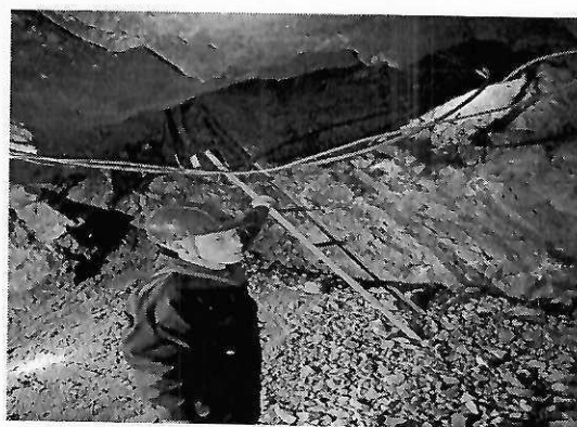
图 2.4 南侧天井下口
