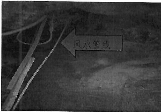
图 4.3 天井内风水管线
