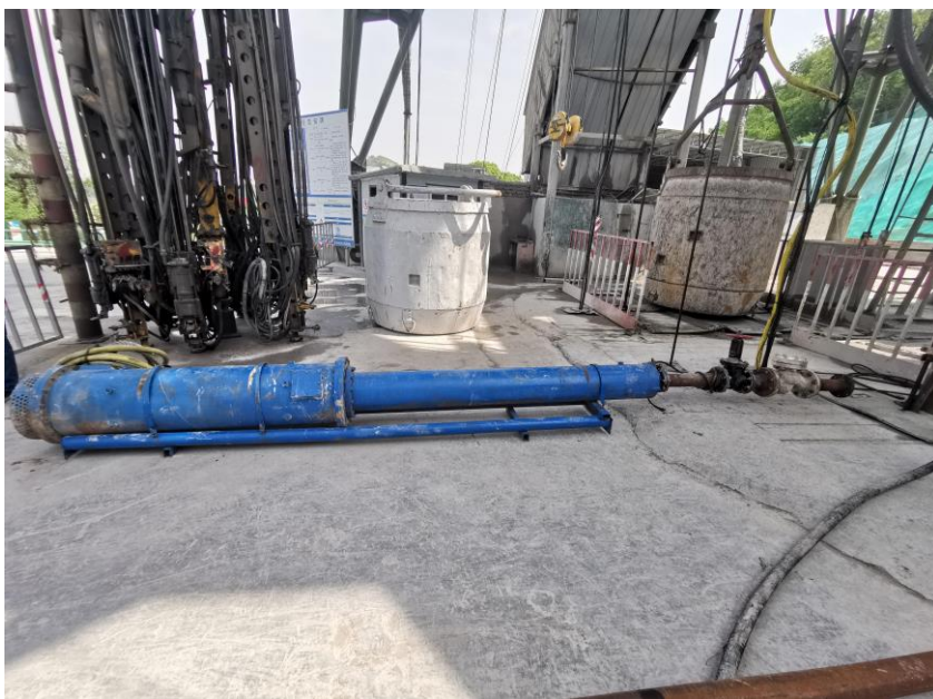
(图 11 事发时吊运的水泵)
