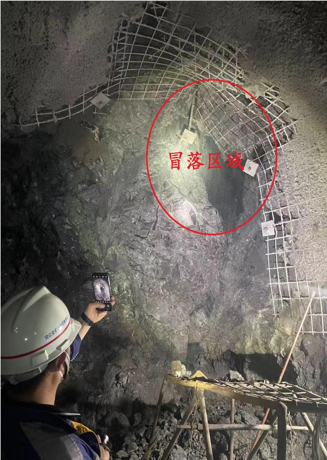
(图 3 裂隙面)
