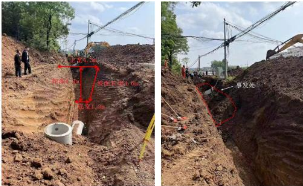
图 2 事故沟槽施工现场图
