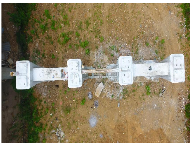
图 2：96 号墩顶部概貌
