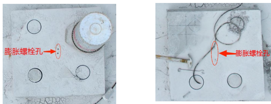
图 4：2 号立柱顶部北侧、南侧支座垫石
