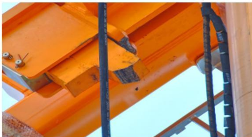
事故塔机爬升架局部（东北向）损伤细节情况
