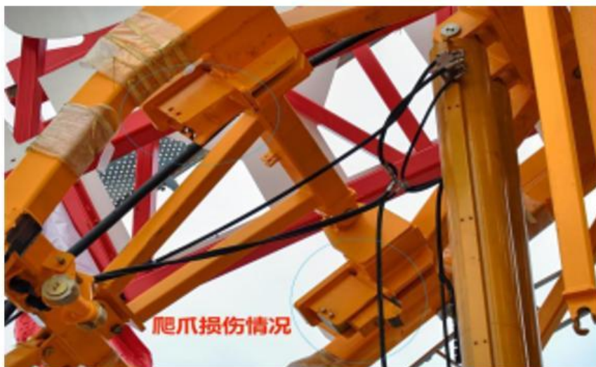
事故塔机爬爪损伤脱落情况
