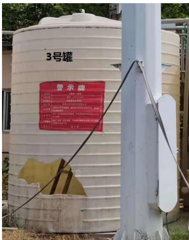
图3 事故罐3号罐南侧救人出口
