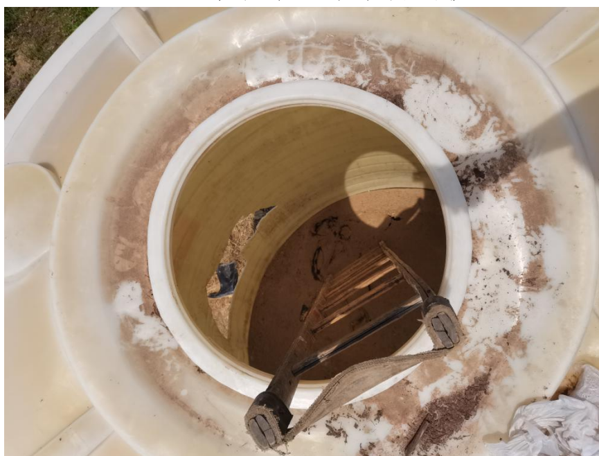
图4 事故罐3号罐管顶部的情况
