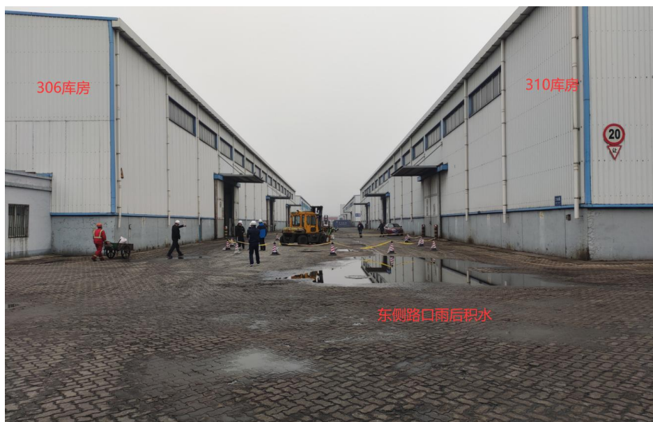
照片二 事故现场
