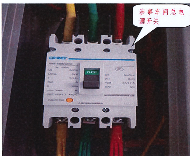
图 6 涉事车间电源总开关
