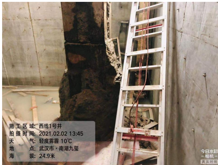
图：现场勘验井下照片（抽水后）
