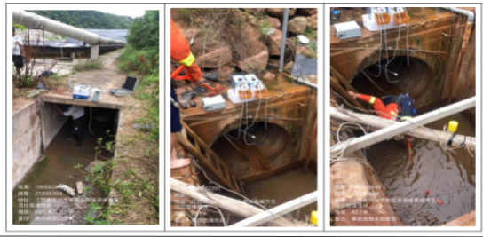
图6 溢流池现场采样
