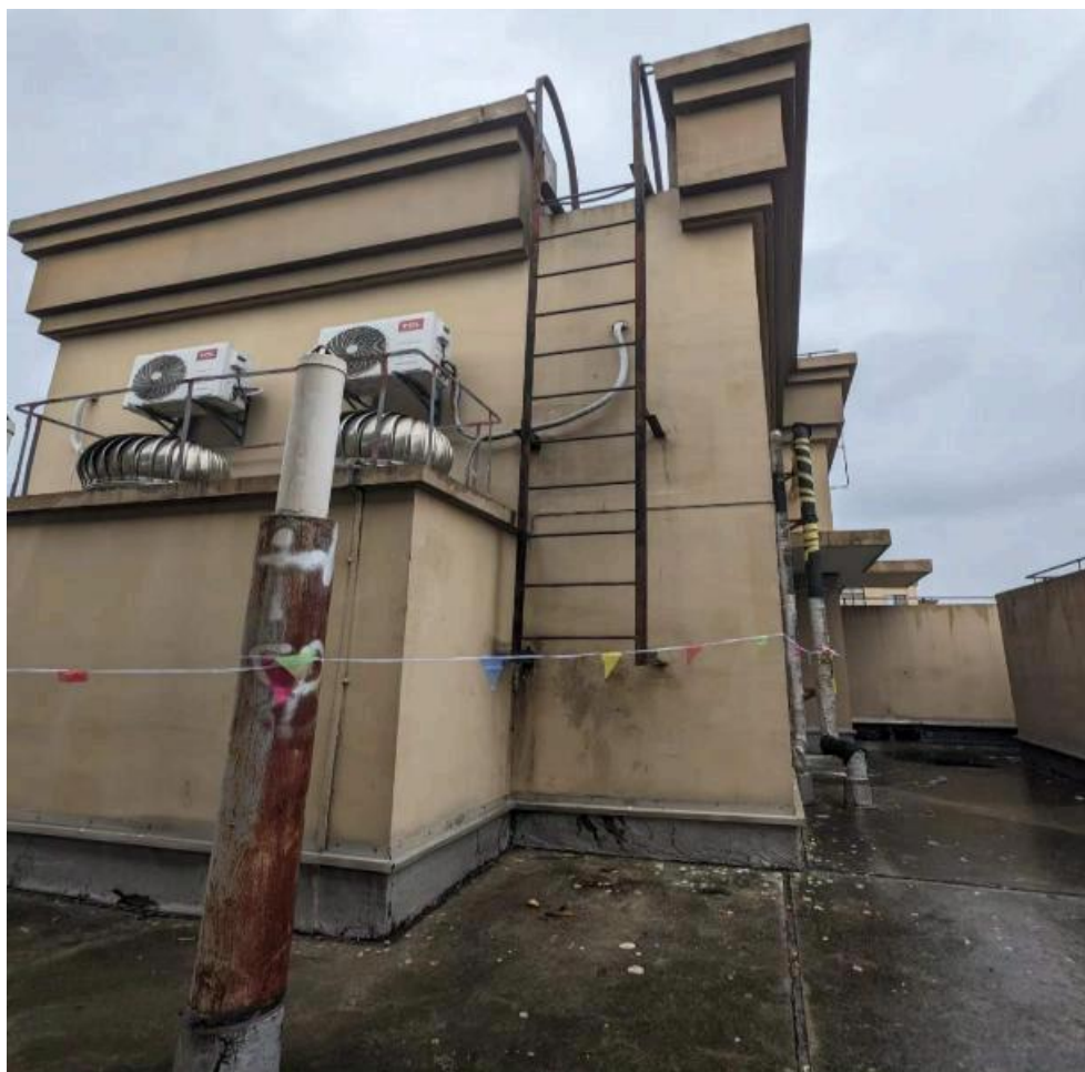
图2 楼顶电梯机房和消防通道阁楼构成的高台
