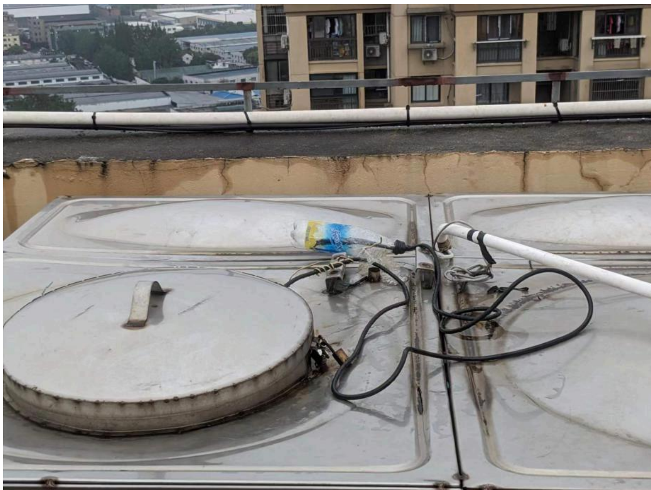
图4 水箱上方的检修口和塑料瓶
