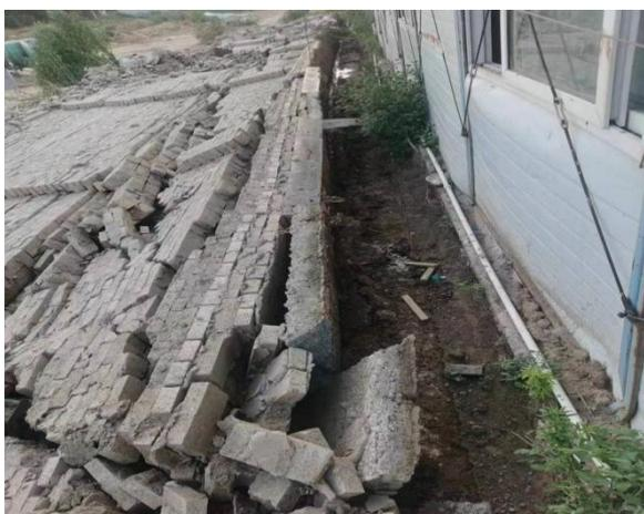
图5 倒塌的墙体基础
