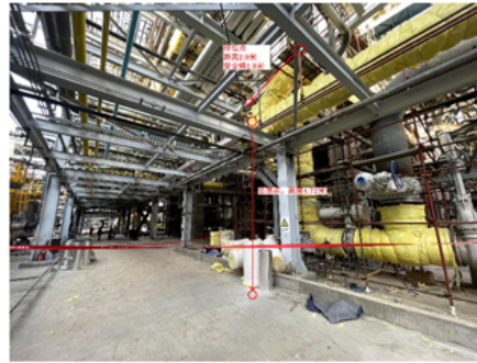
图2 事故发生现场
