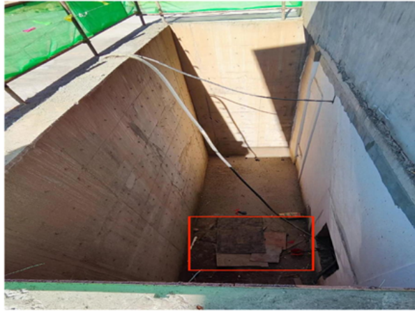
图 4: A 窑通风井俯视图 (通风井深 6 米) 红色框内为刘忠良跌落位置。
