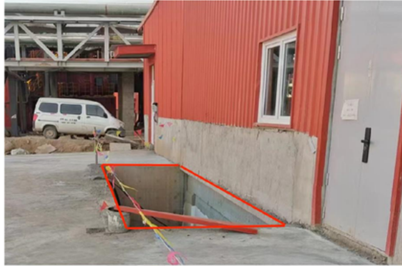
图 3: 事发现场 A 窑通风井平视图 (通风井长 8.6 米, 宽 2.2 米); 通风井周围用彩旗作警示防护。
