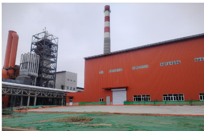
图 7 混凝土浇筑作业区域
