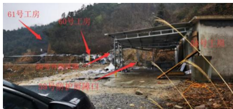
图4：59号回收粉中转工房周边损毁情况
