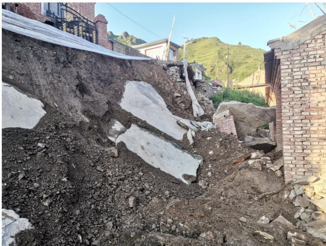
4、羊沙镇大草滩村路基防护工程事故现场图
