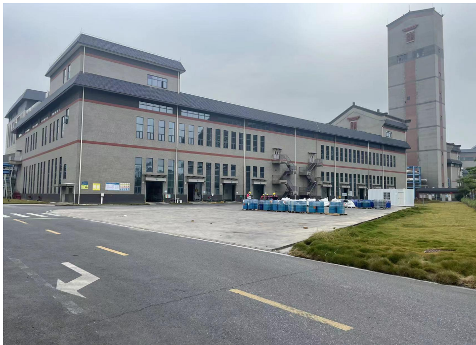
图 2 已竣工的丙类暂存库 2
