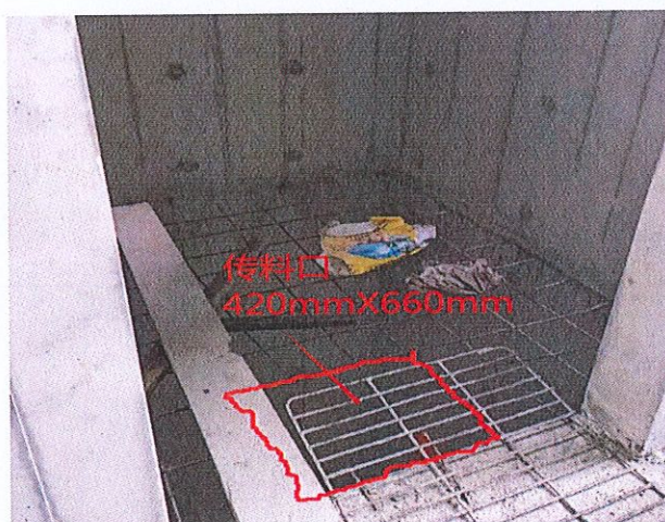
图 3 红圈为事故发生时防护网被剪断的大小
