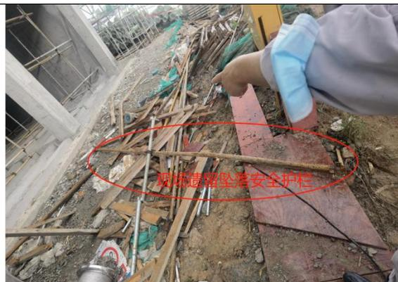
图 5 现场遗留坠落安全护栏
