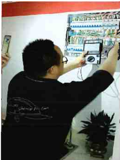
图9 测量接地电阻
