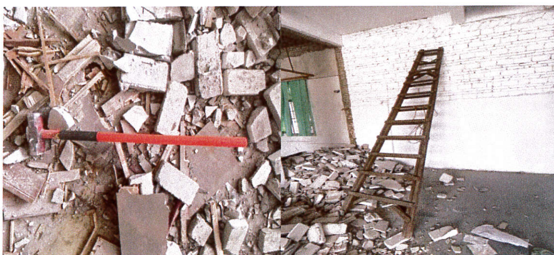
图 5 事故现场留下的施工工具
