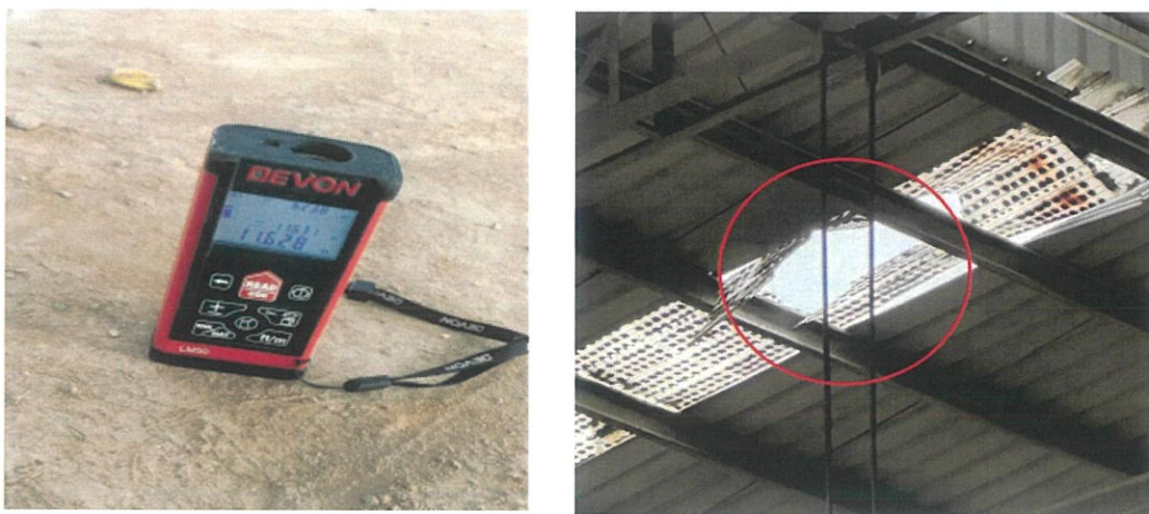
图3 现场激光测距仪实测高度、高处坠落处图
