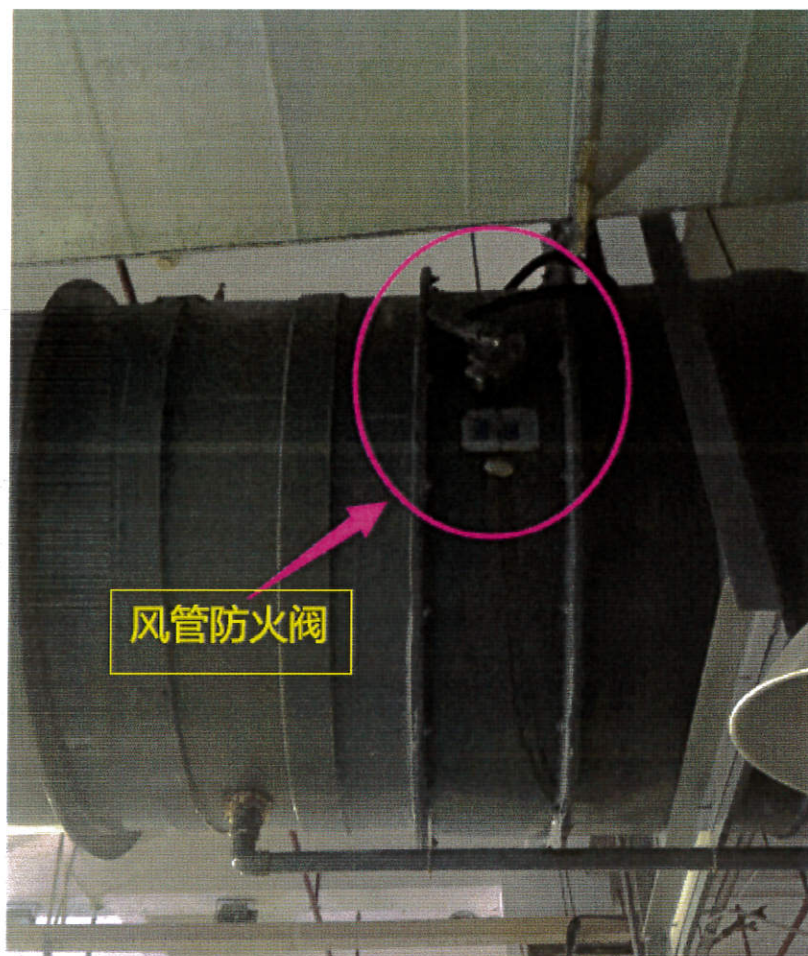
(图八 周边电气设施情况)
