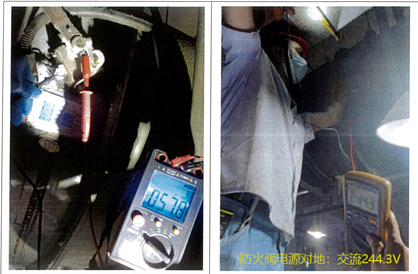
(图十一 对防火阀的电气安全性能检测)
