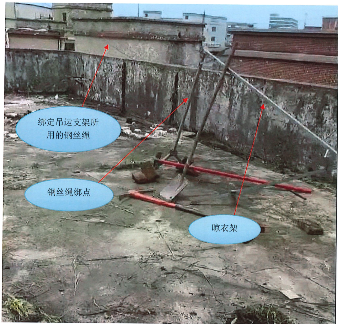
图 10 事发前钢丝绳绑定情况图
