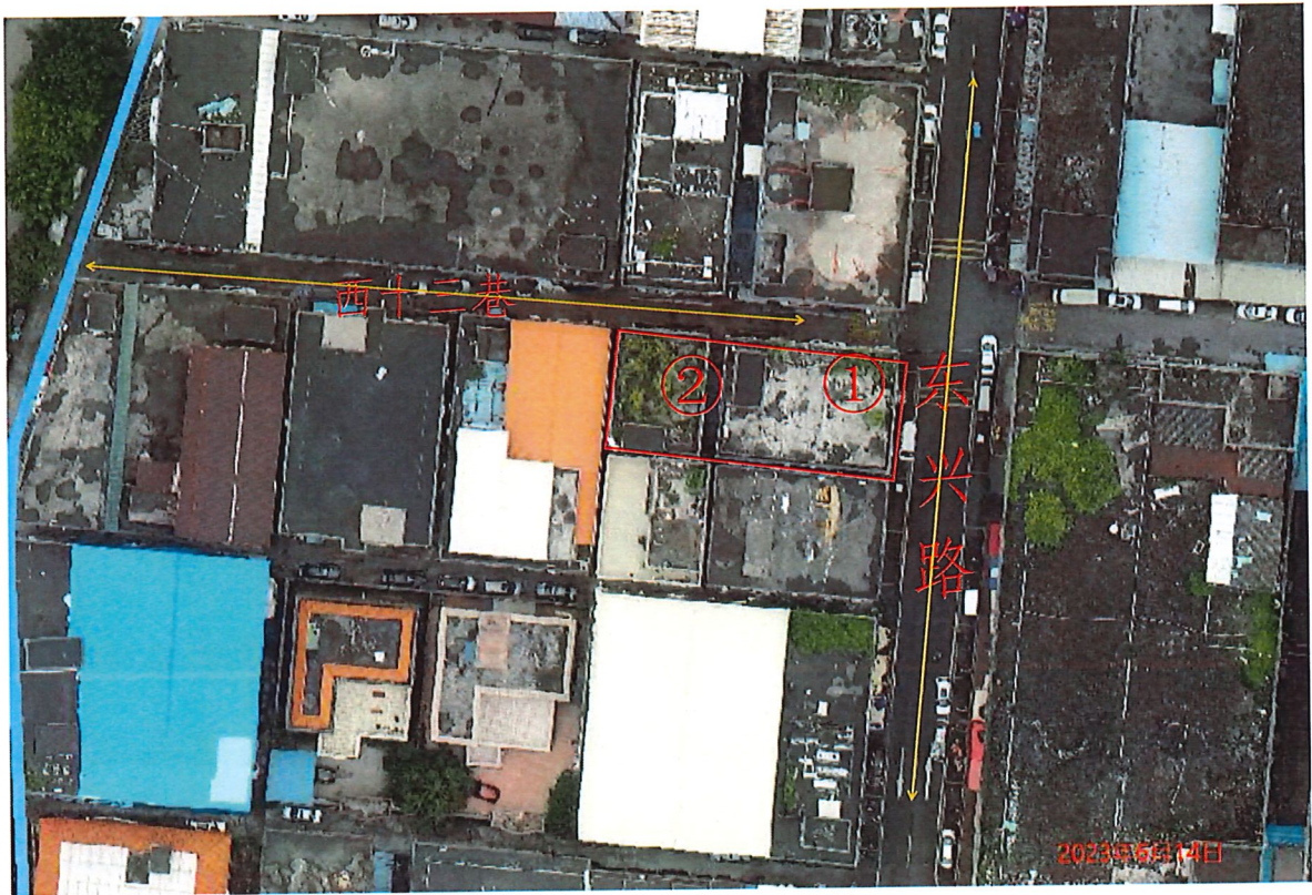
图1 事故发生地俯瞰图
