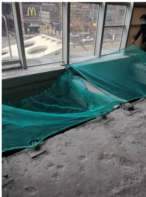
图二 防护网铺设情况
