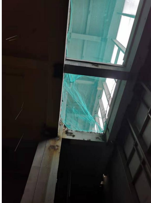
图四 一层上方电梯井洞口
